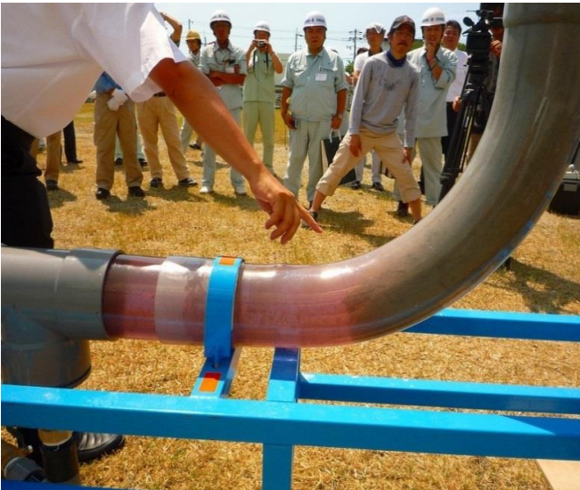
下降管終点部での状況：充填材境界面の確認
