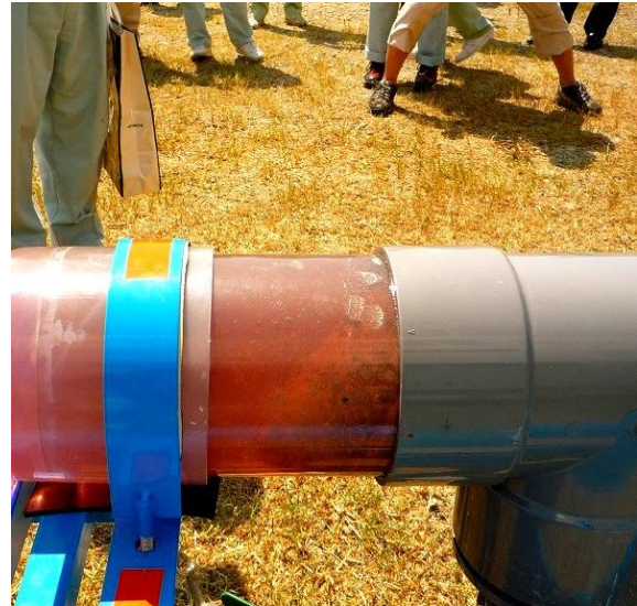
伏せ越し部水平管充填状況
