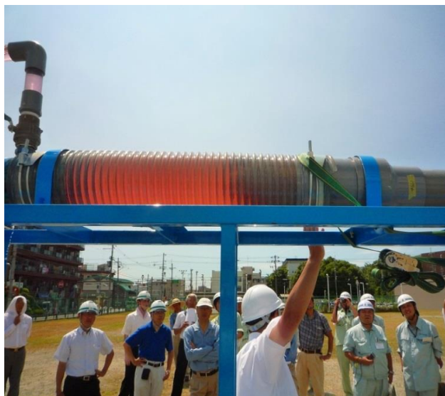
到達側水平部の進行状況：充填材境界面の確認
