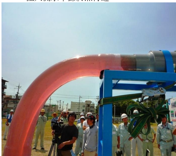
注入側水平部終点付近
