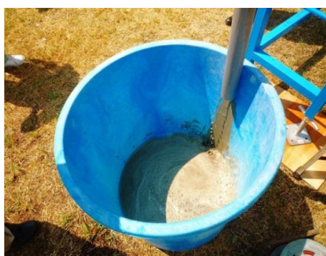
到達側吐出管からの充填材流出確認
