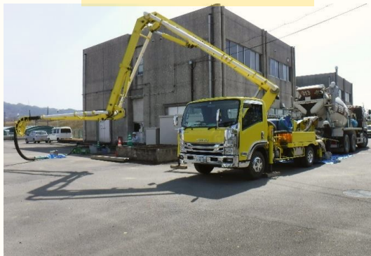
コンクリートポンプ車による注入状況
