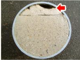
エアモルタル
