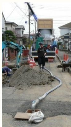
プラント車配置状況
